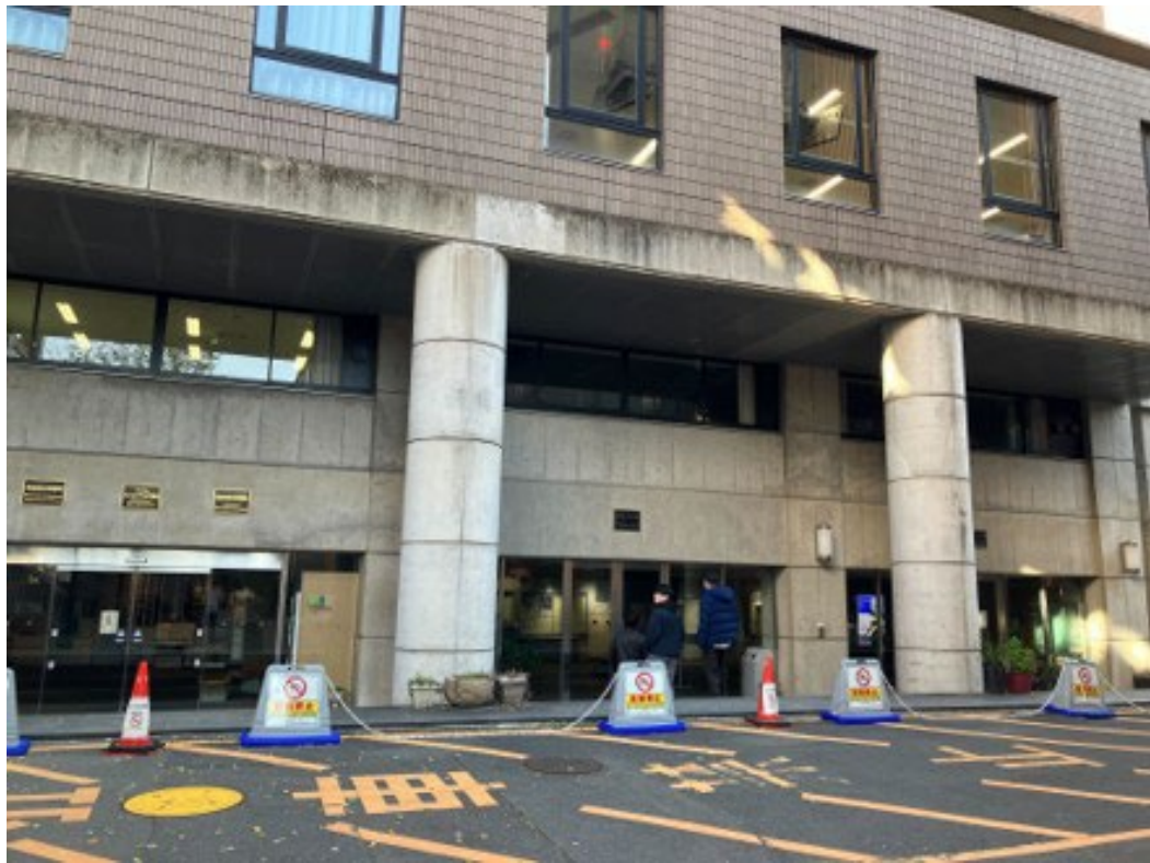
建物入口外観
