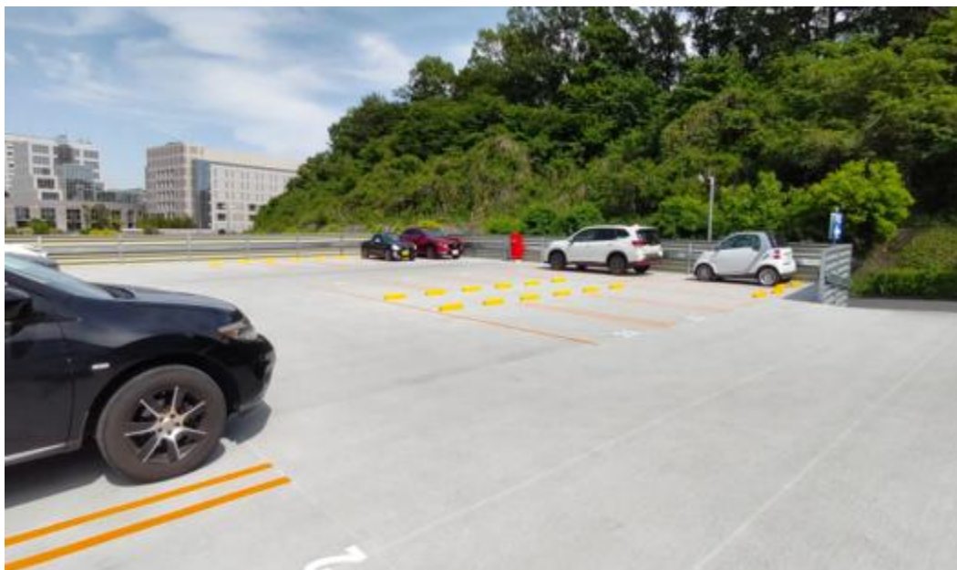
駐車エリア（立体駐車場の2F）の様子 ※ 重量制限（2 t）
